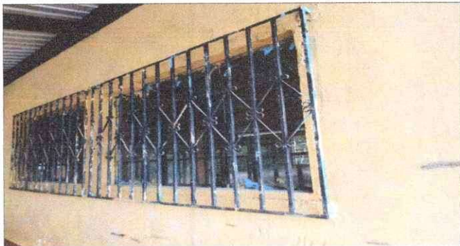
Foto 3: MANTENIMIENTO A ESTRUCTURA DE BALCONES
