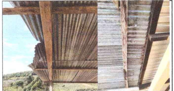
Foto 4: SUSTITUCION DE LAMINAS DETERIORADAS POR LAMINA TROQUELADA ALUZINC
