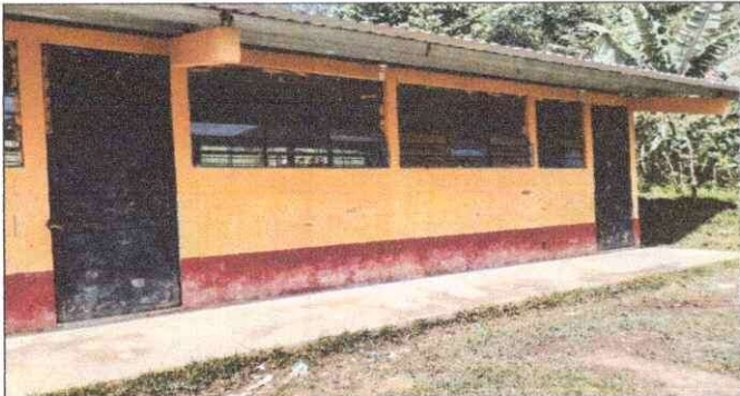
Foto1: MANTENIMIENTO A PUERTA, Y PINTURA EN MURO EXTERIOR E INTERIOR
