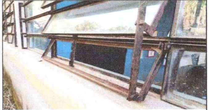
Foto 2: SUSTITUCION DE VIDRIOS QUEBRADOS Y FALTANTES, MODULO 4, 3 Y 2
