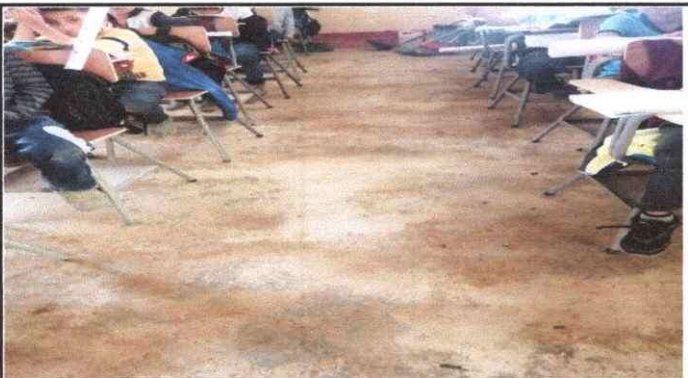
Foto 9: SE REQUIERE SUSTITUCION A PISO CERAMICO
